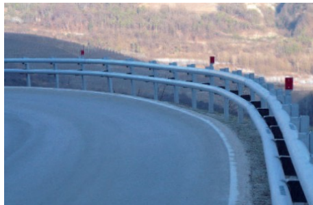
Studio, progettazione, costruzione dei prototipi e crash test barriera PAT con relative omologazioni in collaborazione con Ing. Demozzi.
