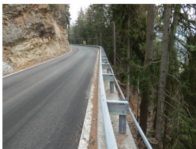
Studio, progettazione, costruzione dei prototipi e crash test barriera PAB in collaborazione con Università di Milano facoltà Aereostaziale con relative omologazioni
