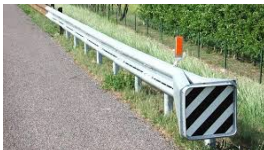
Studio, progettazione, costruzione dei prototipi e crash test con relative omologazioni del primo terminale realizzato in Europa in collaborazione con Università di Milano facoltà Aereostaziale
